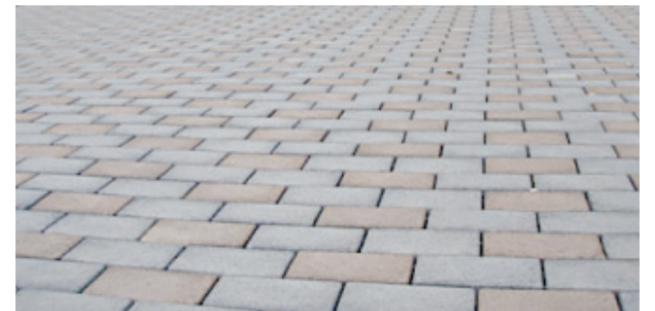
Imagem 111 - Piso intertravado de concreto utilizado nos estacionamentos para demarcá-los e para facilitar a absorção de água. Fonte: <http://abnt.org.br/>
